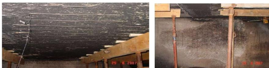
Рис. 2. Железобетонные перекрытия автостоянки после пожара
