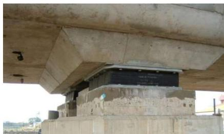
Рис. 1. Использование демпферов в мостовых сооружениях
