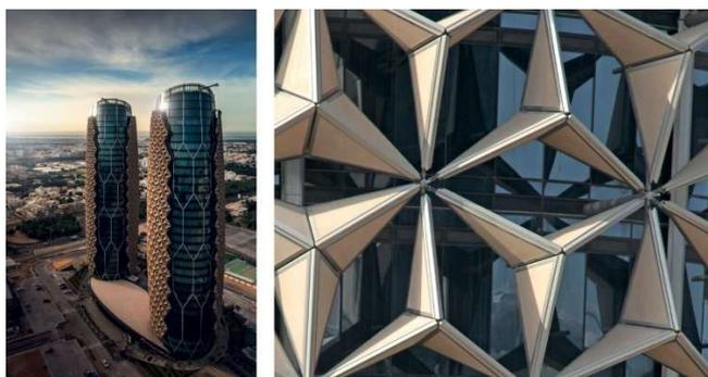
Рис. 1. Адаптивный фасад башен Al Bahr в Абу-Даби
