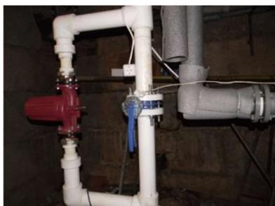
Рис. 2. Циркуляционный насос
