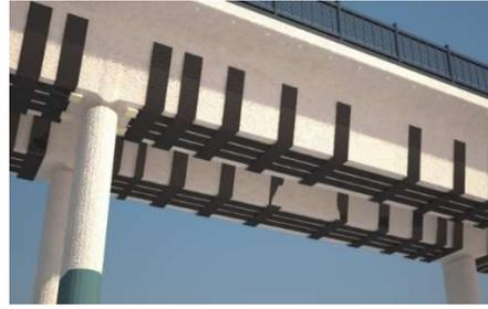
Рис. 4. Укрепление моста композитными материалами
